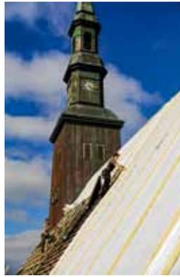
soweit sie unversehrt sind, werden wieder genutzt. Mit ihnen soll der südliche Eingang gedeckt werden. Alle anderen Flächen werden mit neuem Schiefer gedeckt. Als Unterfütterung wird eine Holz-
