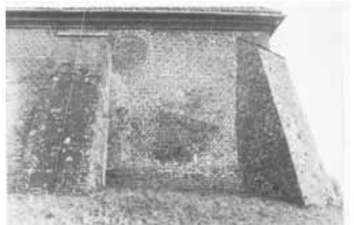
Kirche Langhaus W-Teil mit Stützpfeilern von Norden, Aufnahme 8/1934-3/1935
